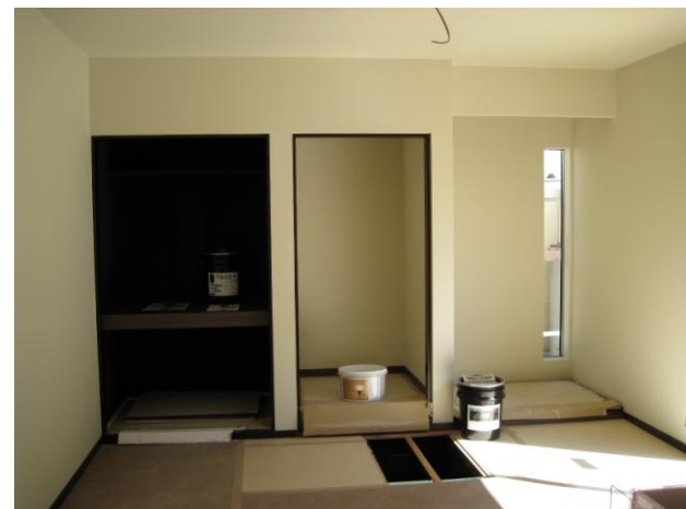
和室押入れ 施工例です
